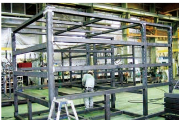
大型パイプフレームの溶接
