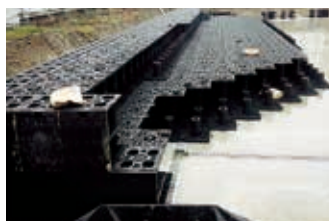
樹脂製雨水地下貯留ブロック(ゲリラ豪雨対策)
